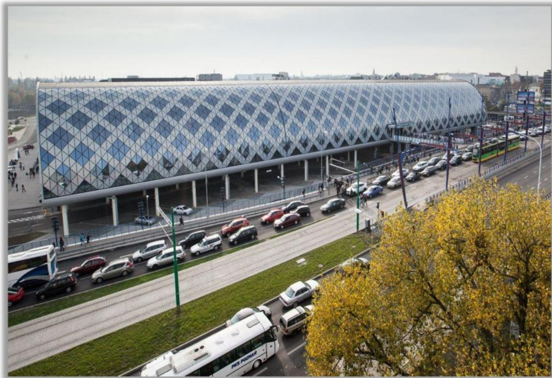
Figure 6: Poznań Główny (Post-redevelopment) 44
